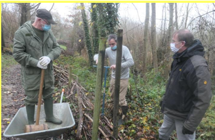
Tarière pour forer le trou et maillet pour enfoncer le pieu Grondboor en hamer voor het plaatsen van de paal
